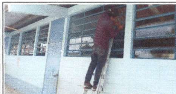
Foto 5: Sustitución de vidrios de las aulas.
